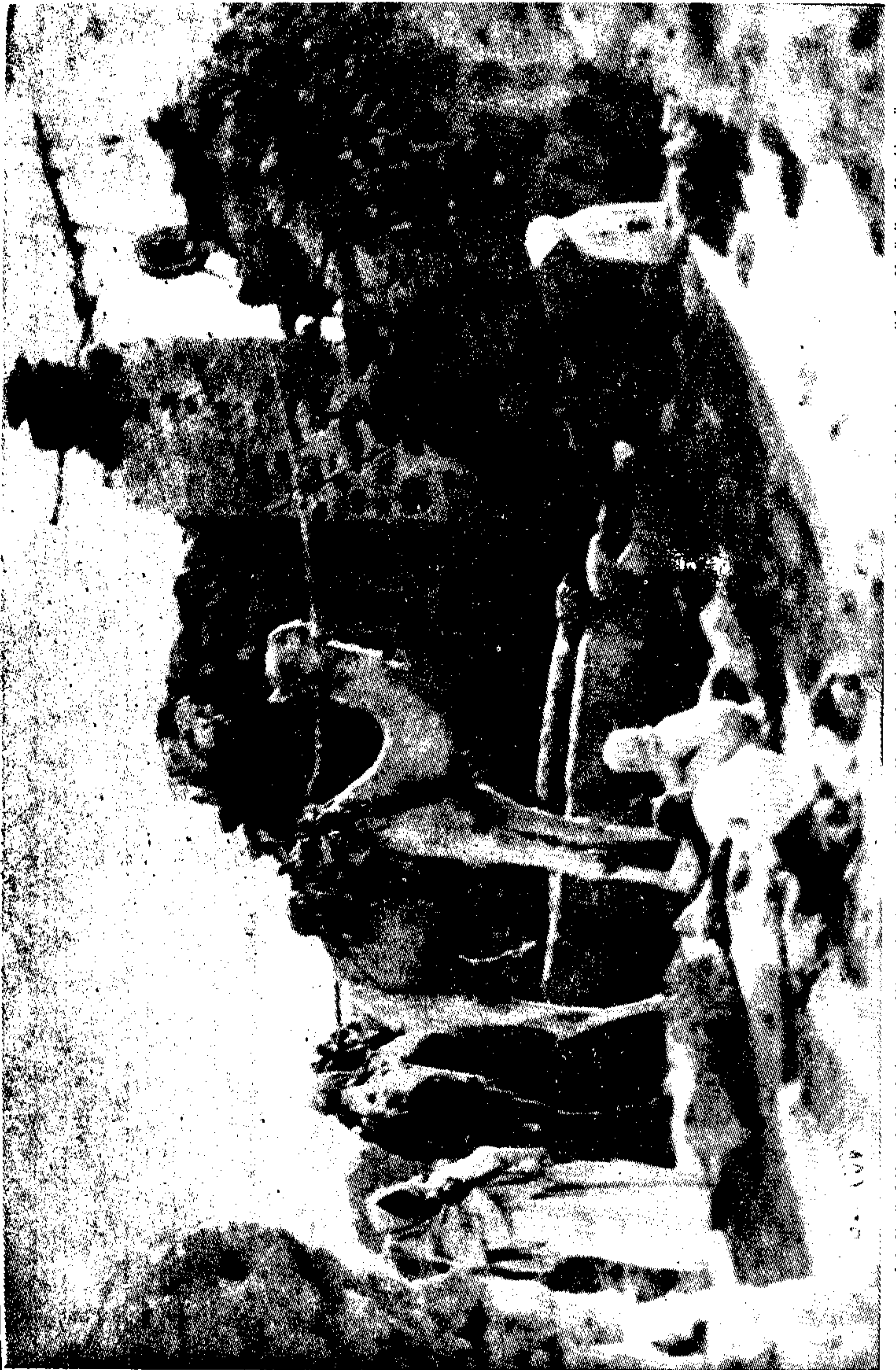
صورة تمثل السائية التي كانت تستعمل في المدينة للري في الزراعة وقد ظهرت الجمال التي تجر الادايه والذي يسوقها والجز والبكرة والرشاء .
