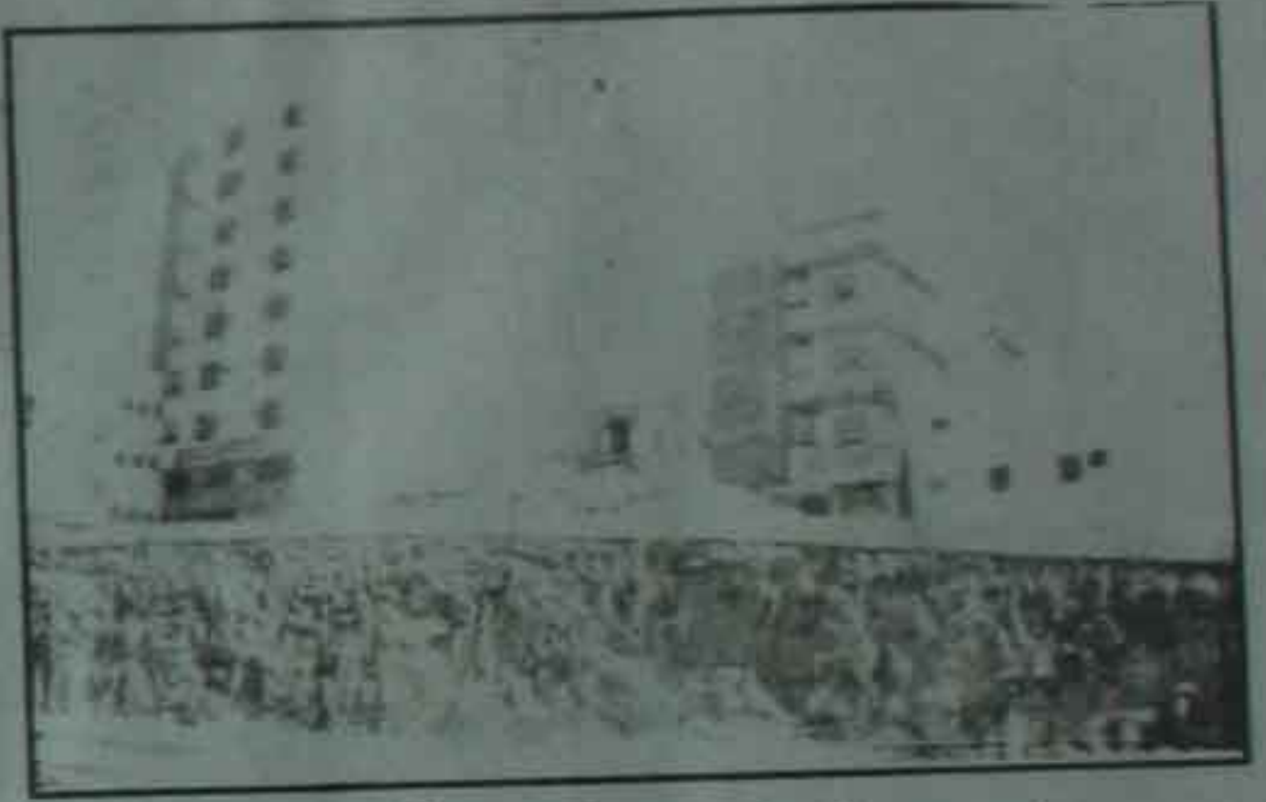
مدینہ منورہ جدیدہ عمارتوں کے درمیان پتھروں سے تعمیر کردہ قدیم عمارت
